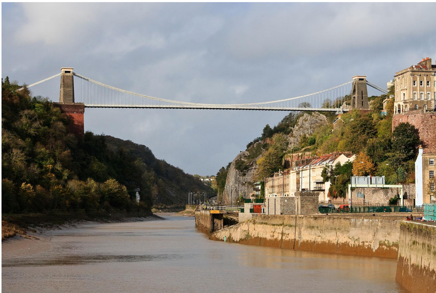
Clifton suspension bridge, Αγγλία.
